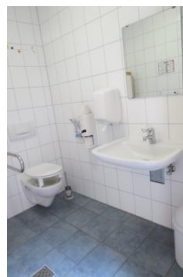
WC im Rezeptionsgebäude
